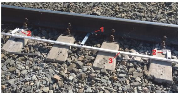
Рис. 3. Размещение магнитных меток для локальных
